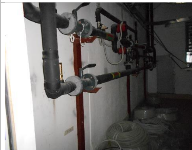
Фото 39. Внутреннее состояние помещения 667,8 кв. м.
