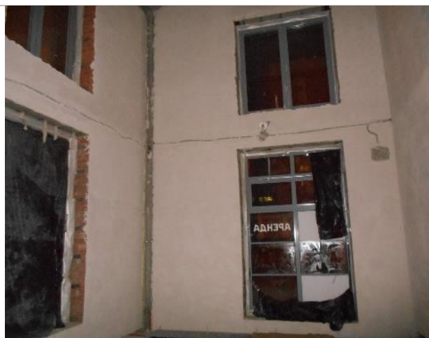
Фото 21. Внутреннее состояние помещения 667,8 кв. м.
