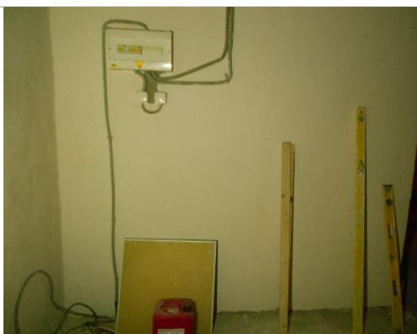
Фото 58. Внутреннее состояние помещения 667,8 кв. м.
