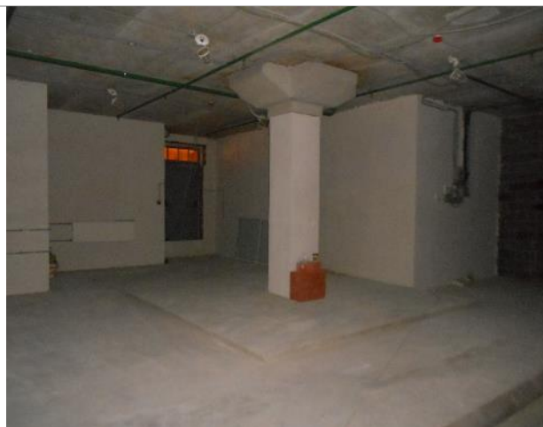
Фото 31. Внутреннее состояние помещения 667,8 кв. м.
