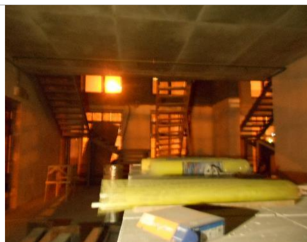
Фото 29. Внутреннее состояние помещения 667,8 кв. м.
