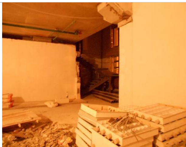
Фото 15. Внутреннее состояние помещения 667,8 кв. м.
