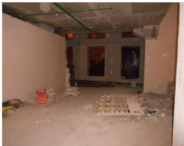
Фото 18. Внутреннее состояние помещения 667,8 кв. м.
