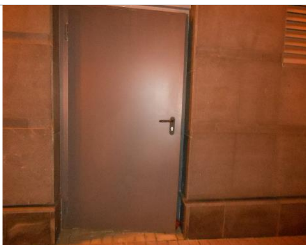
Фото 60. Запасной вход помещения 667,8 кв. м.
