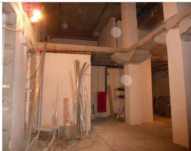
Фото 14. Внутреннее состояние помещения 667,8 кв. м.
