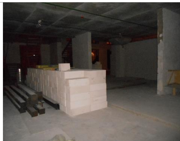
Фото 27. Внутреннее состояние помещения 667,8 кв. м.
