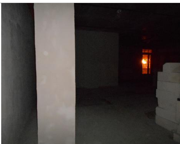
Фото 24. Внутреннее состояние помещения 667,8 кв. м.
