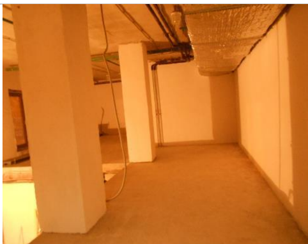
Фото 54. Внутреннее состояние помещения 667,8 кв. м.
