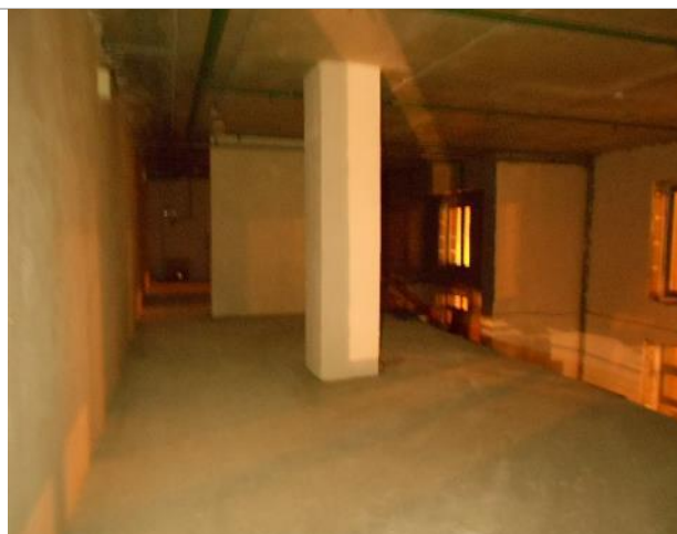
Фото 53. Внутреннее состояние помещения 667,8 кв. м.
