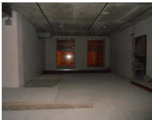
Фото 35. Внутреннее состояние помещения 667,8 кв. м.
