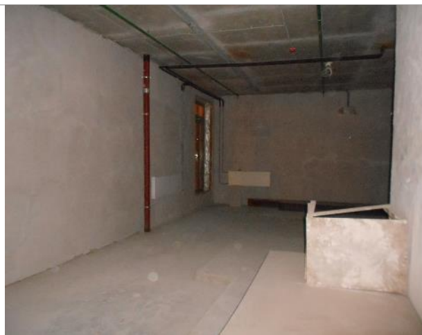
Фото 26. Внутреннее состояние помещения 667,8 кв. м.
