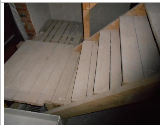
Фото 41. Внутреннее состояние помещения 667,8 кв. м.
