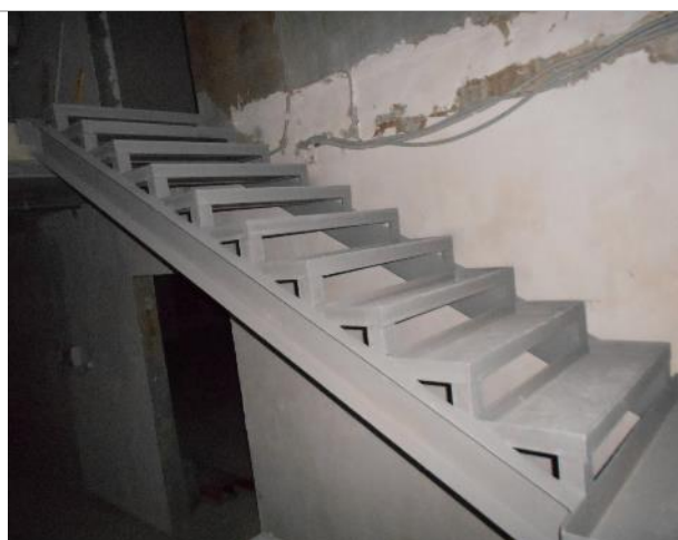
Фото 42. Внутреннее состояние помещения 667,8 кв. м.
