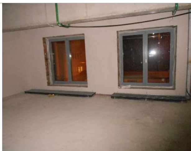
Фото 45. Внутреннее состояние помещения 667,8 кв. м.
