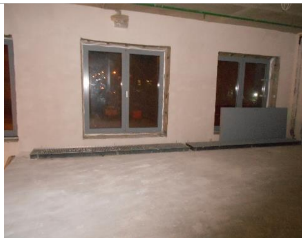
Фото 55. Внутреннее состояние помещения 667,8 кв. м.
