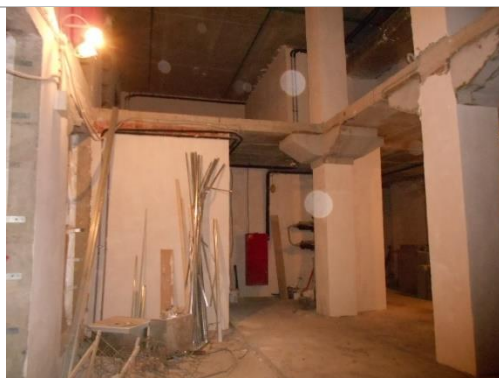
Фотография 3.4. Внутренние помещения объекта 667,8 кв. м
