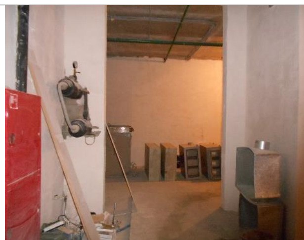
Фото 5. Внутреннее состояние помещения 667,8 кв. м.
