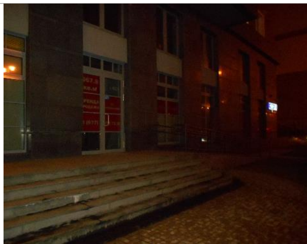
Фото 62. Запасной вход помещения 667,8 кв. м.
