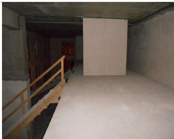
Фото 38. Внутреннее состояние помещения 667,8 кв. м.
