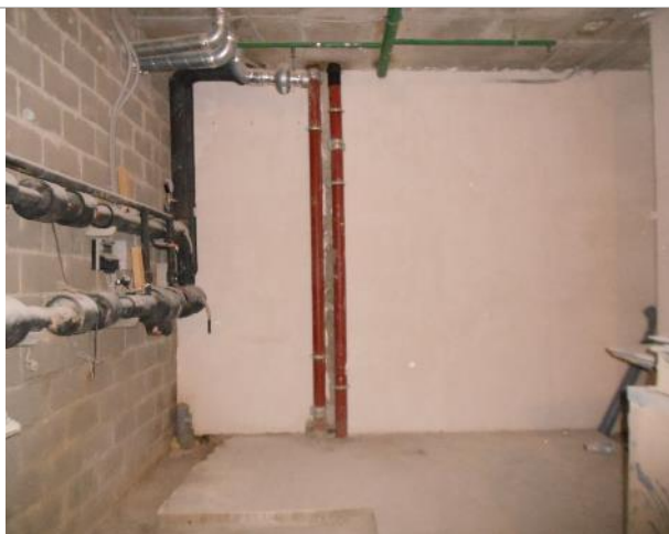
Фото 8. Внутреннее состояние помещения 667,8 кв. м.
