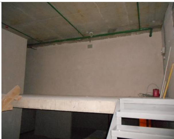
Фото 44. Внутреннее состояние помещения 667,8 кв. м.
