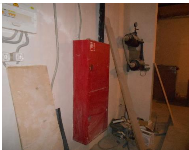
Фото 6. Внутреннее состояние помещения 667,8 кв. м.
