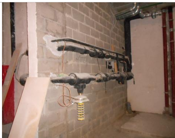
Фото 9. Внутреннее состояние помещения 667,8 кв. м.
