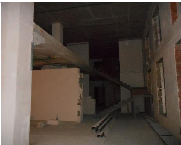
Фото 22. Внутреннее состояние помещения 667,8 кв. м.
