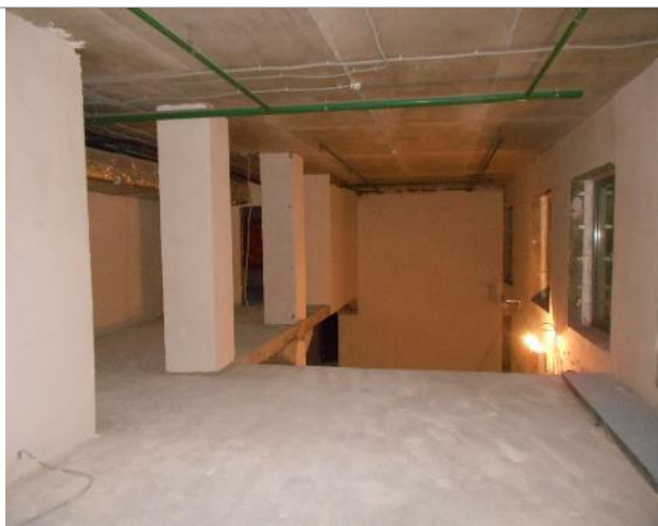
Фото 56. Внутреннее состояние помещения 667,8 кв. м.
