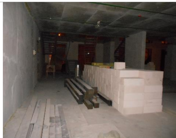
Фото 25. Внутреннее состояние помещения 667,8 кв. м.
