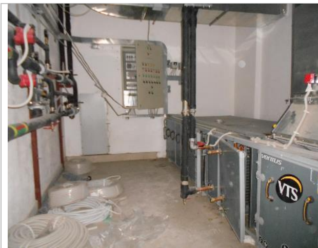
Фото 37. Внутреннее состояние помещения 667,8 кв. м.
