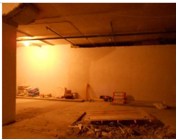
Фото 11. Внутреннее состояние помещения 667,8 кв. м.
