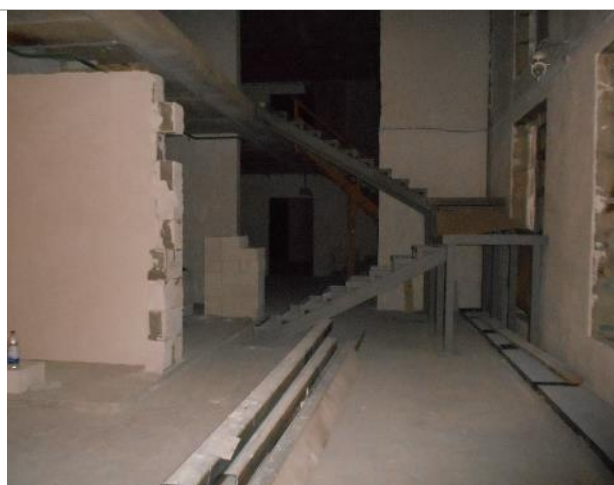
Фото 23. Внутреннее состояние помещения 667,8 кв. м.
