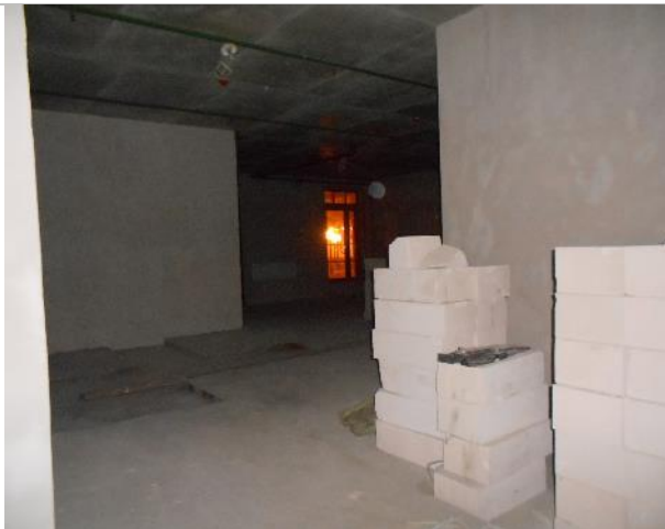
Фото 20. Внутреннее состояние помещения 667,8 кв. м.
