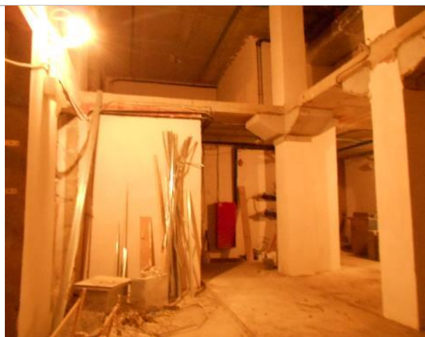
Фото 16. Внутреннее состояние помещения 667,8 кв. м.
