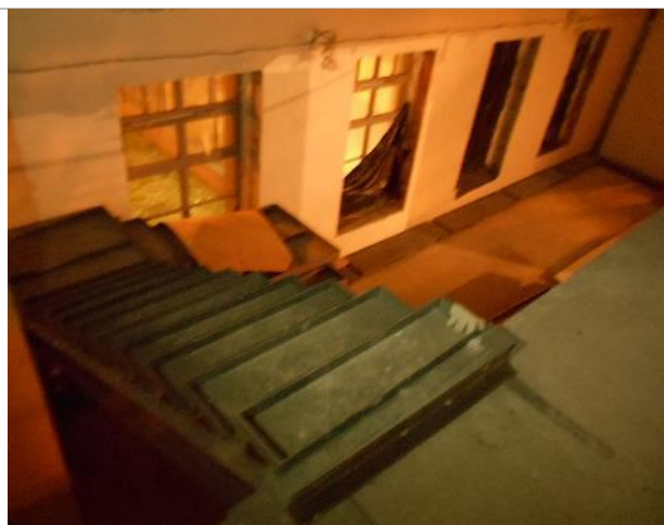
Фото 51. Внутреннее состояние помещения 667,8 кв. м.
