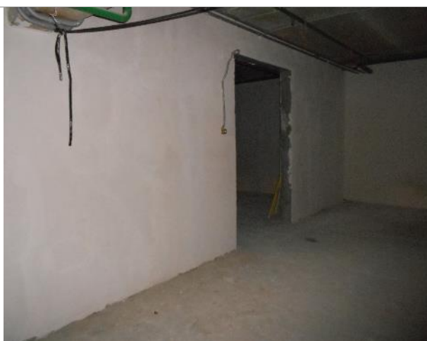
Фото 48. Внутреннее состояние помещения 667,8 кв. м.
