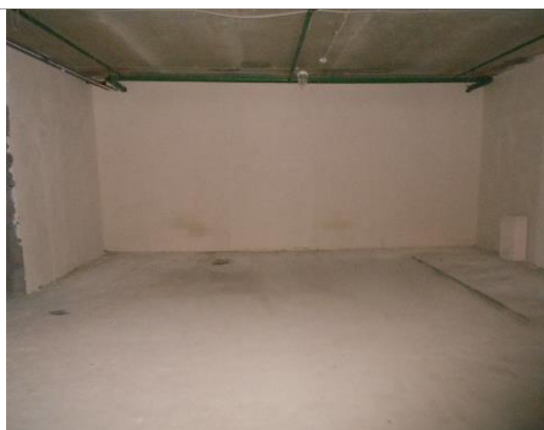
Фото 47. Внутреннее состояние помещения 667,8 кв. м.
