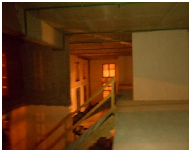
Фото 49. Внутреннее состояние помещения 667,8 кв. м.
