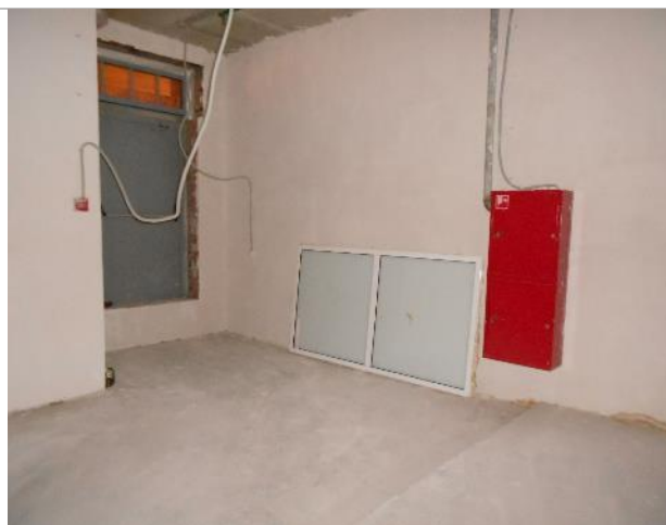
Фото 33. Внутреннее состояние помещения 667,8 кв. м.
