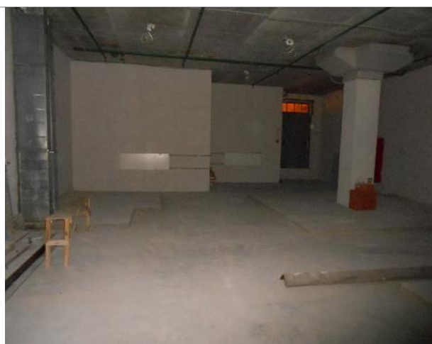
Фото 30. Внутреннее состояние помещения 667,8 кв. м.
