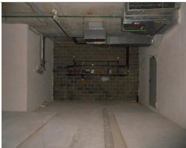
Фото 32. Внутреннее состояние помещения 667,8 кв. м.
