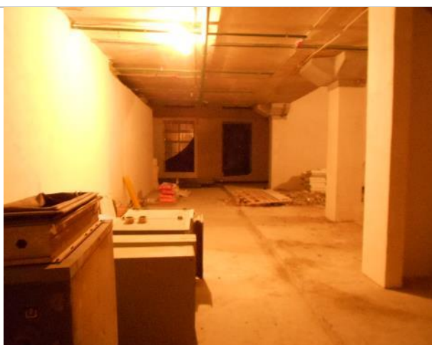
Фото 12. Внутреннее состояние помещения 667,8 кв. м.
