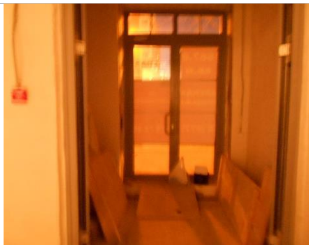
Фото 2. Внутреннее состояние помещения 667,8 кв. м.
