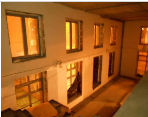
Фото 50. Внутреннее состояние помещения 667,8 кв. м.
