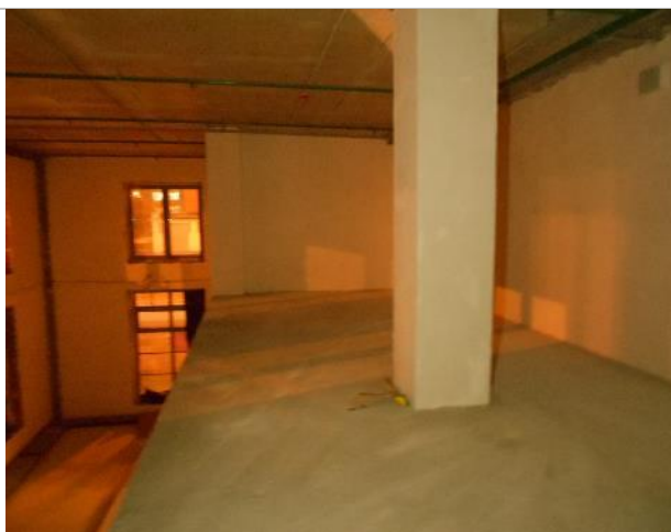
Фото 52. Внутреннее состояние помещения 667,8 кв. м.
