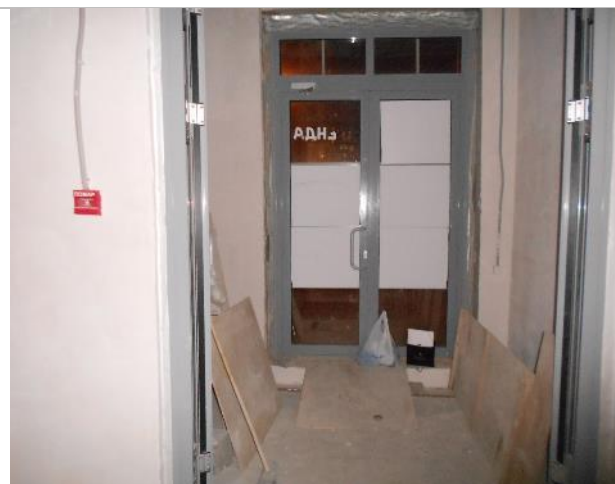
Фото 3. Внутреннее состояние помещения 667,8 кв. м.
