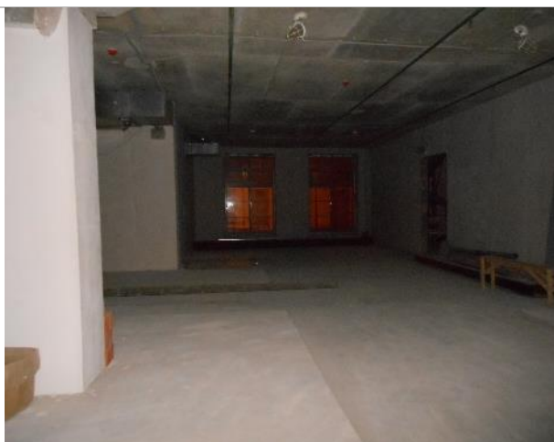
Фото 34. Внутреннее состояние помещения 667,8 кв. м.
