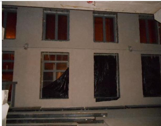
Фото 19. Внутреннее состояние помещения 667,8 кв. м.
