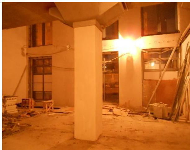
Фото 13. Внутреннее состояние помещения 667,8 кв. м.
