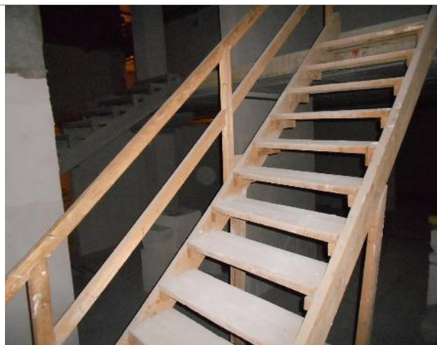
Фото 43. Внутреннее состояние помещения 667,8 кв. м.
