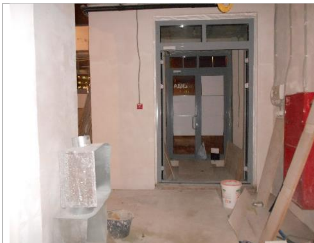
Фото 7. Внутреннее состояние помещения 667,8 кв. м.
