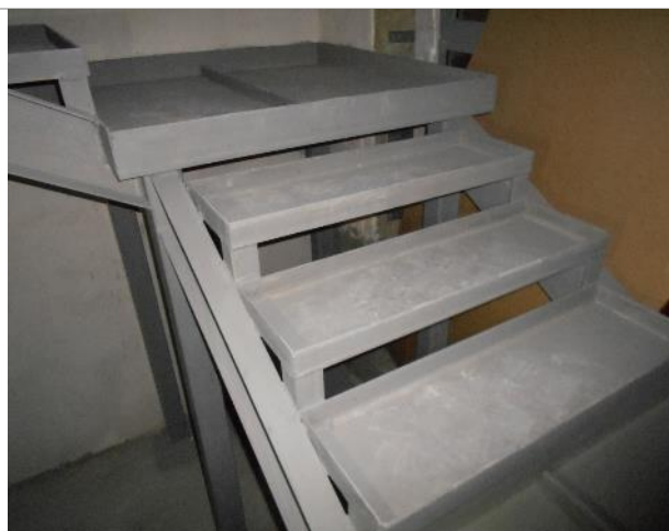
Фото 40. Внутреннее состояние помещения 667,8 кв. м.
