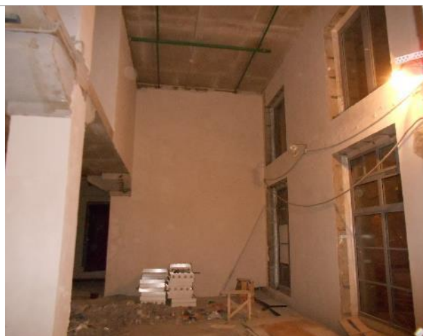
Фото 17. Внутреннее состояние помещения 667,8 кв. м.
