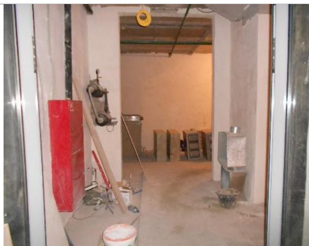
Фото 4. Внутреннее состояние помещения 667,8 кв. м.
