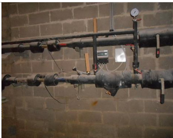
Фото 10. Внутреннее состояние помещения 667,8 кв. м.
