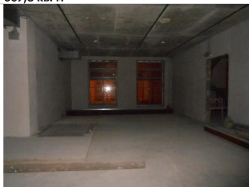
Фотография 3.5. Внутренние помещения объекта 667,8 кв. м
