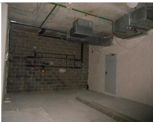
Фото 36. Внутреннее состояние помещения 667,8 кв. м.
